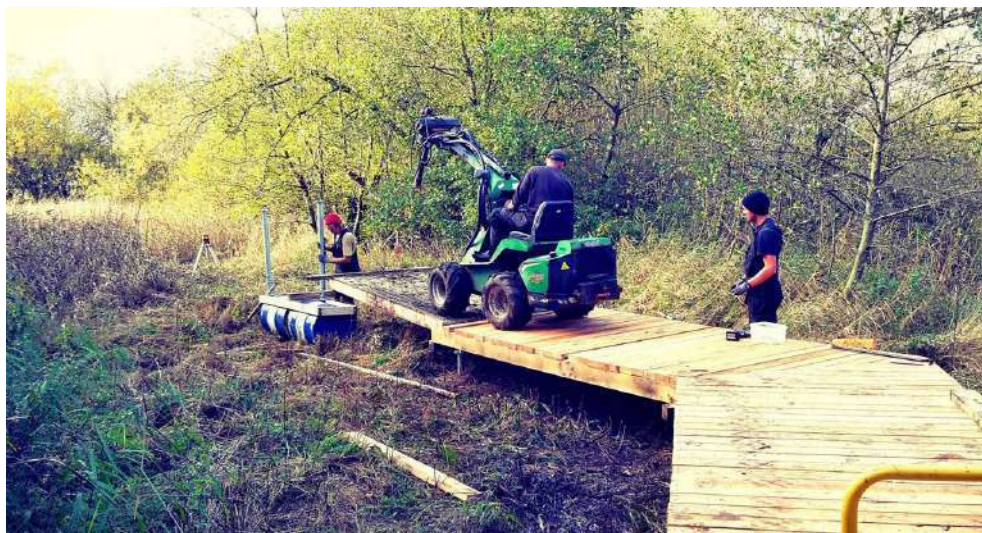
Skruefundering af boardwalk i vådt terræn. Midlertidigt trædæk fungere som arbejdsvej.
