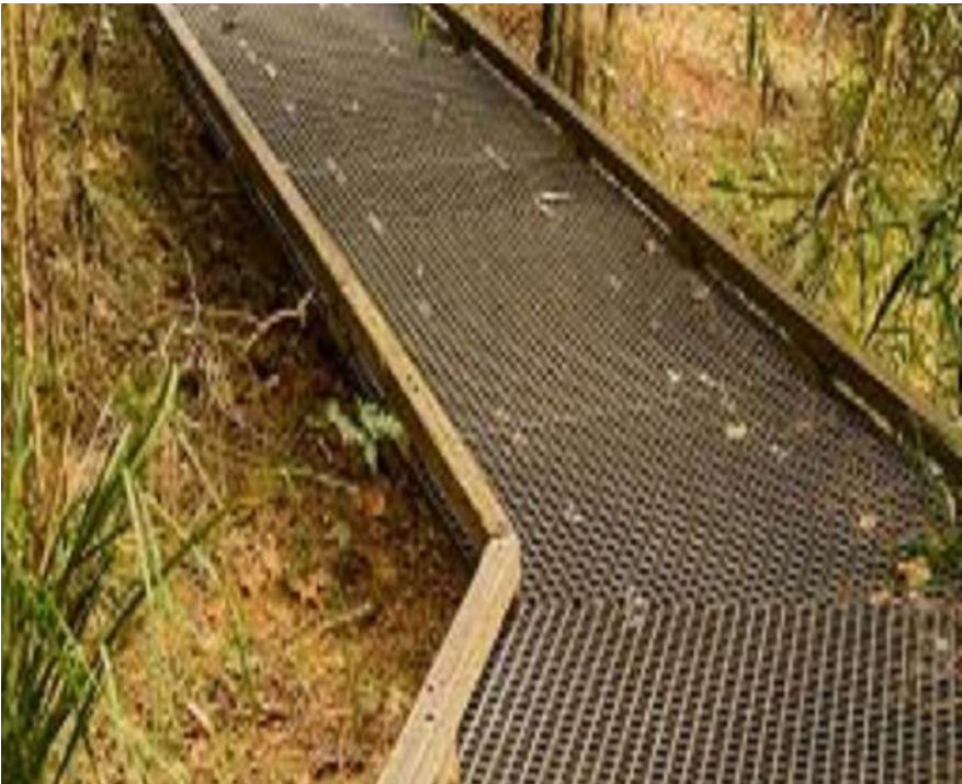
Rist af galvaniseret stål med trækanter. Risten vil til at starte med fremstå grå, men vil patineret i miljøet fremstå som på billedet.
