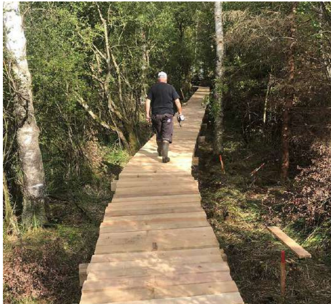
Søndemølle Å, Viborg. Boardwalk på skrufundamenter. Anlagt i et smalt spor uden påvirkning af omgivende natur.
