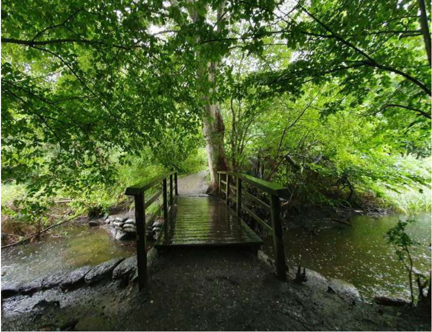
Eksisterende bro (ca. 1,2 x 4 m) som erstattes af Bro 2. Broen er i dag næsten umulig at krydse i kørestol pga. terrænforskellen. Broen er desuden smal, og det kraftige rækværk forhindrer udsynet til de 2 søer. De eksisterende træer bevares, og den nye bro etableres helt tæt omkring dem.
