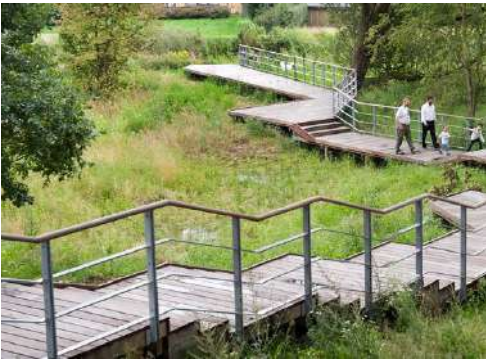
Typereference for Bro 2 og 3: Eksempler på lette rækværk i stål med runde gribevenlige håndlister.
