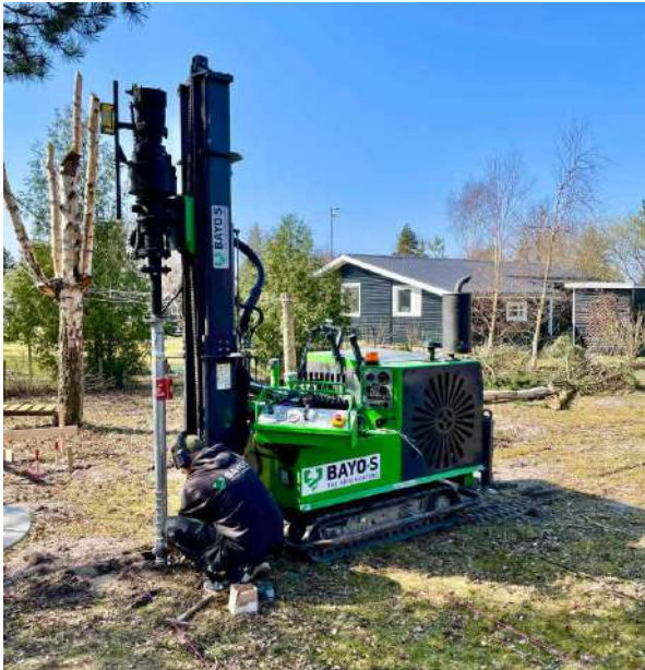
Eksempel på minirambuk til skruefundamenter
