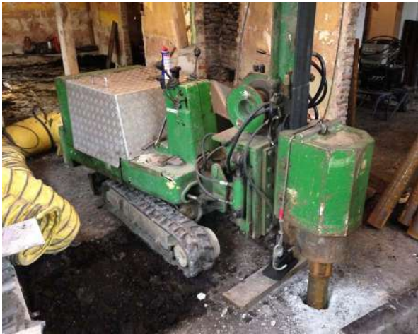
Eksempel på minidumper tilnedramning af minipæle
