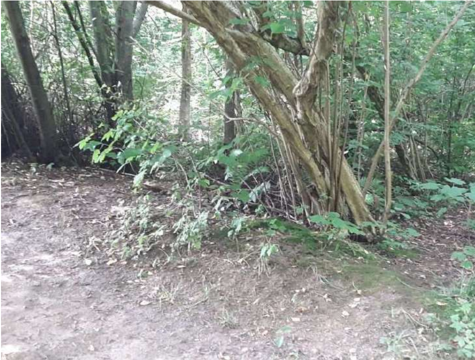
Fig. 5. Den nordligste ende af jorrdiget, set mod vest. På dette sted går der en eksisterende trampesti over som næsten har borteoderet resterne af diget. Denne ende af diget er ikke særlig tydelig, da der kun er bevaret en ganske lav vold. Man fornemmer ikke rigtig, at der er forskel på diget og terrænet hverken på vest- eller østsiden (fotoet snyder, så diget ser tydeligere ud).
