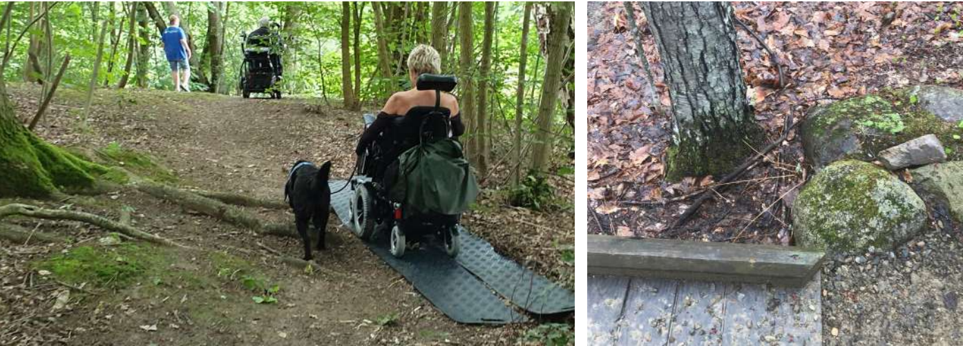
TV: Stierne reguleres ift. terrænet for at opnå den rette hældning, men også for at opnå en planhed der gør det muligt at færdes i kørestol uden at skulle medbringe tunge hjælpemidler. Trærødder, sten og lokale lavninger kan forhindre at det er muligt for personer med bevægelseshandicap at komme ud i naturen.
