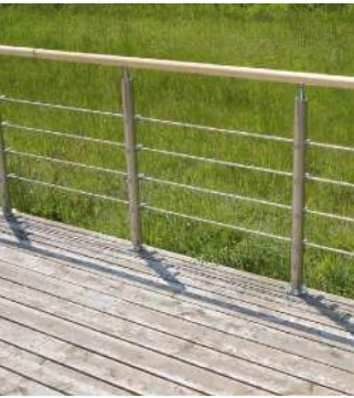
Typereference for Bro 2 og 3: Eksempler på lette rækværk i stål med runde gribevenlige håndlister.
