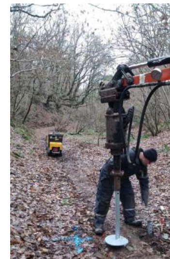
Skruefundering med minigraver på larvefodder
