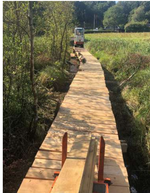
Søndemølle Å, Viborg. Boardwalk på skrufundamenter. Anlagt i et smalt spor uden påvirkning af omgivende natur.
