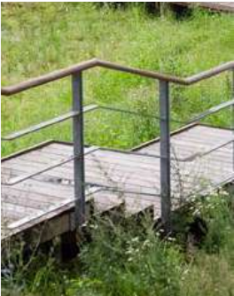
Materialerference for håndliste. Udføres i galvniseret stål
