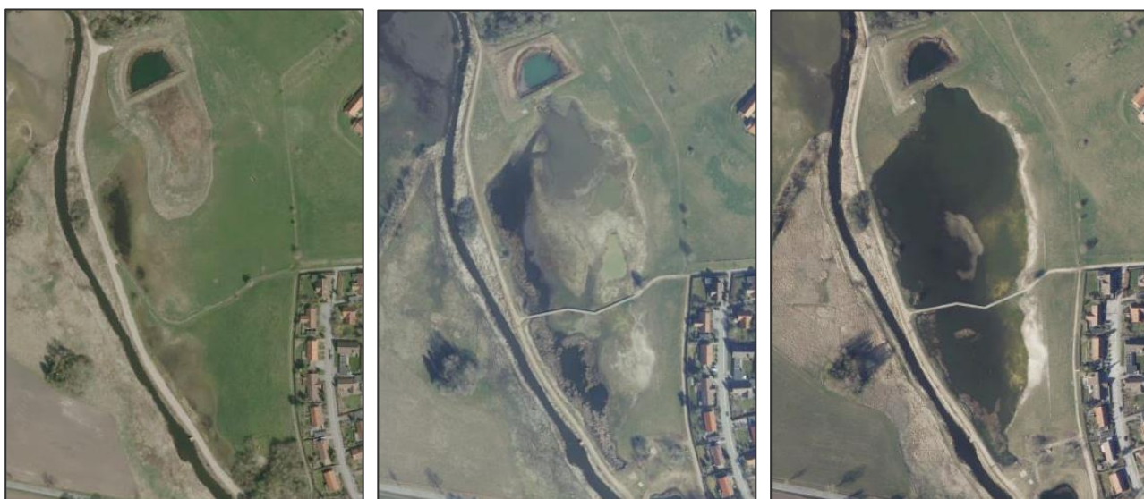
Figur 9-1 Før og efter billeder af projektet i Ringsted Ådal. Projektet blev gennemført som et led i separatkloakering af Ringsted. Fra venstre et billede fra projektet (2018) og to billeder efter projektet, med varierende udnyttelse af kapaciteten (2021 og 2022).
