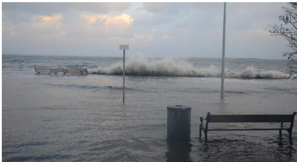
Figur 5-8 Foto fra Bukkeballevvej d. 6. december 2013 under stormen, Bodil. Koten på Rungsted Strandvej er her ca. +2,1 m (DVR90) og vandstanden vurderes til ca. +1,7 m (DVR90). Det store bølgeoverskyl skyldes at stenglaciset foran vejen er støbt med beton mellem stenene, hvilket giver en meget glat overflade og meget større bølgeoverskyl end ved en stenkastning med porøsitet.
