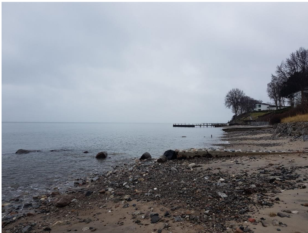
Figur 3-21 Kysten på den sydligste delstrækning set mod syd. Bemærk den nedbrudte betonhøfde ca. udfør Immortellevej.
