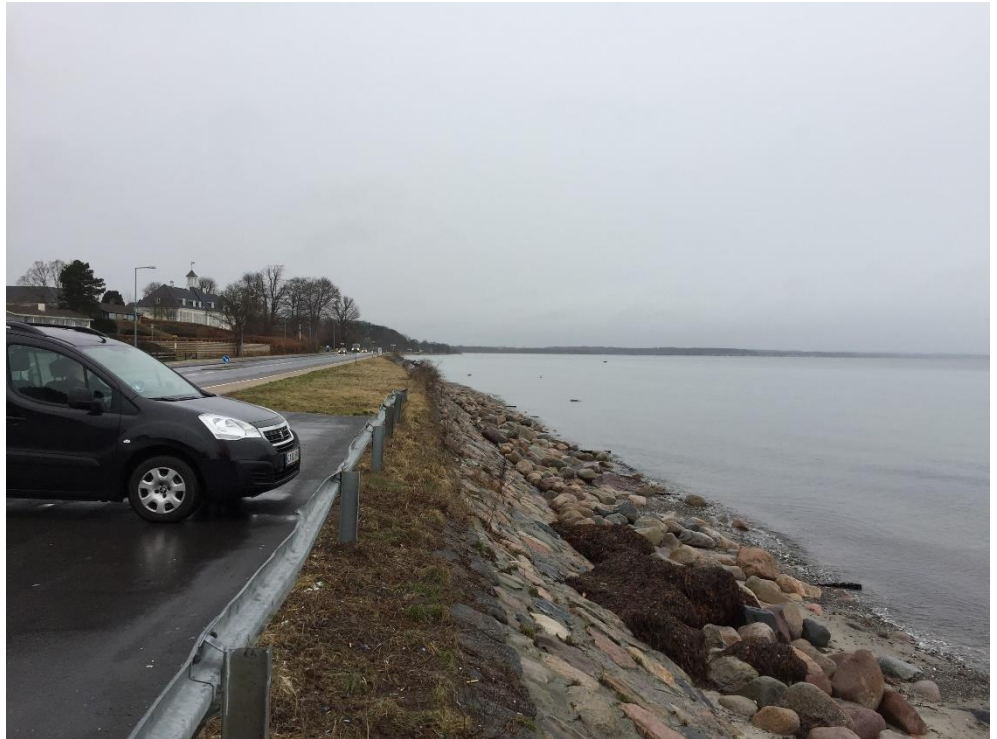
Figur 3-8 Kysten set mod nord ved parkeringspladsen lidt syd for Sophienberg Slot (slottet ses i baggrunden til venstre).
