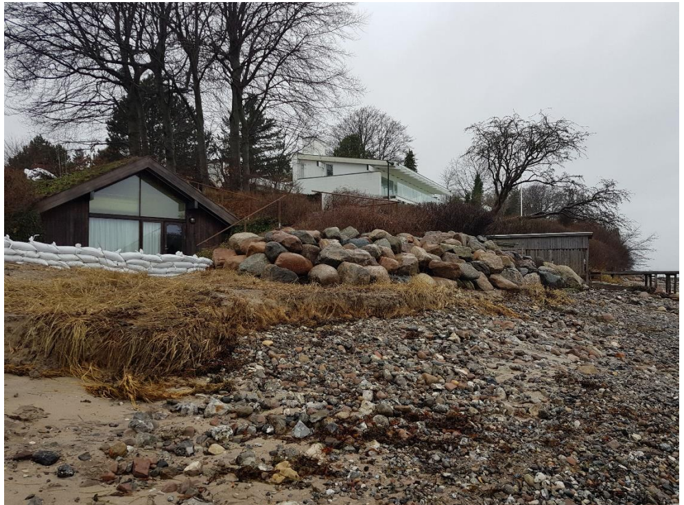
Figur 3-24 Eksempel på skræntfodsbeskyttelse på den sydligste delstrækning. Bemærk den kraftige stenkastning og tilstødende sandsække.
