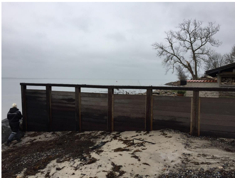
Figur 3-1 Kysten set mod syd fra den nordligste delstrækning.
