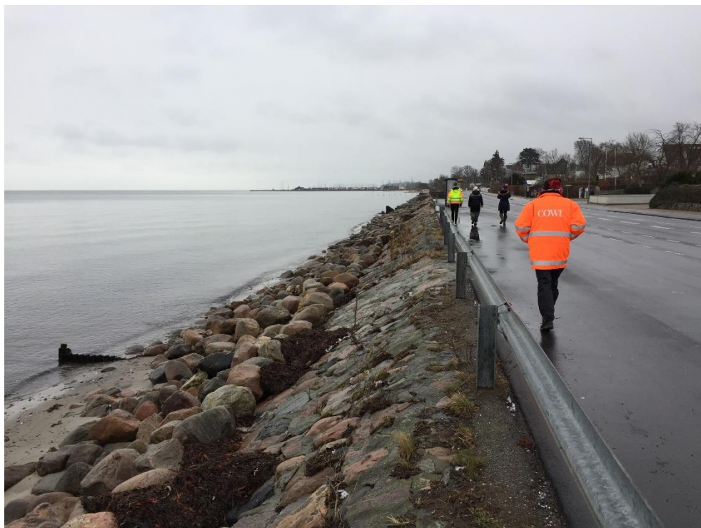
Figur 3-10 Kysten set mod syd umiddelbart syd for Bukkeballevvej.
