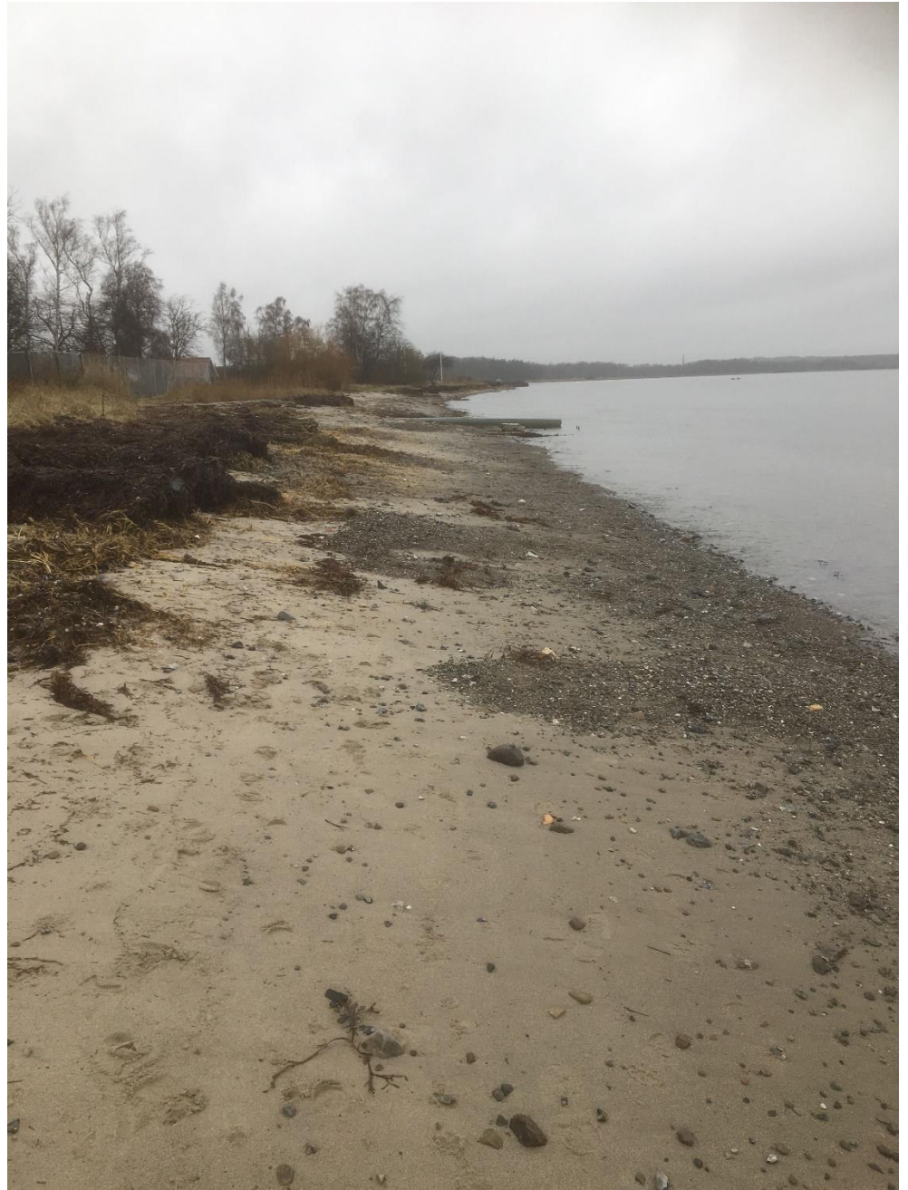
Figur 3-3 Kysten set mod nord på stranden ved den nordligste kystmatrikel i kommunen.
