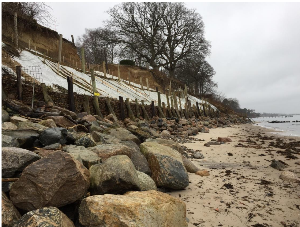
Figur 3-25 Kysten nedenfor Egetoftevej hvor ejeren er ved at lave en sikring af skrænten, som er under skred, og som dermed har bragt de gamle egetræer på grunden i risiko for at falde ned på stranden.
