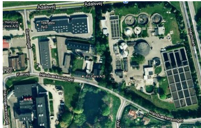
Figur 7-7: Usserød renselanlæg øverst til højre er placeret umiddelbart ved siden af Nordforbrænding
