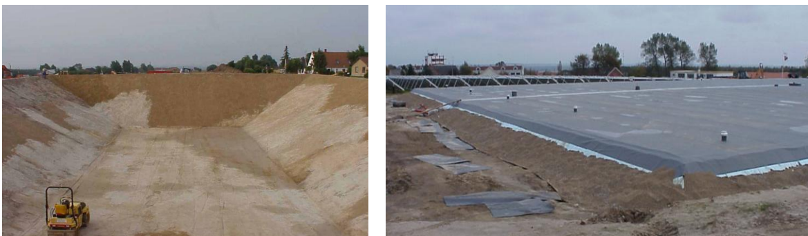
Figur 7-13: Billeder fra 10.000 m 3 damvarmelager ved Marstal. Udgravning og færdigt lager med låg.
