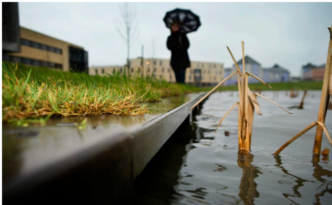
Regnvand bruges til rekreative formål ved Himmerland Boligforening i Aalborg.
